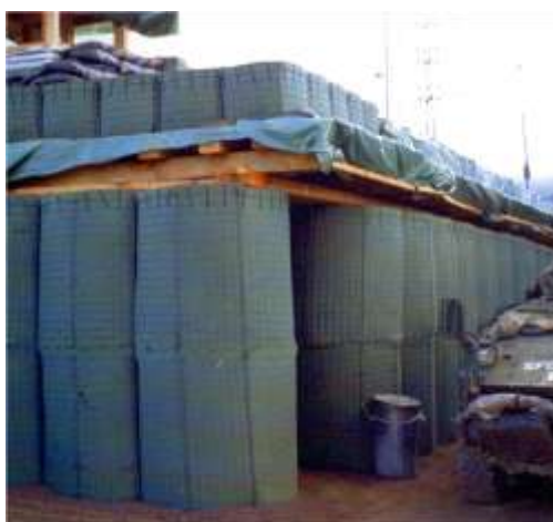
Figura 3-14 - Utilização do sistema Hesco-Bastian na construção de abrigos
