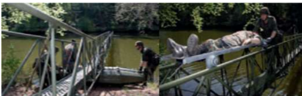
Figura 2-8 - Passadiço ligeiro para tropas a pé. Repare-se na figura à direita no transporte de baixas
